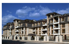
SIRENA RESIDENCE, Słoneczny Brzeg
